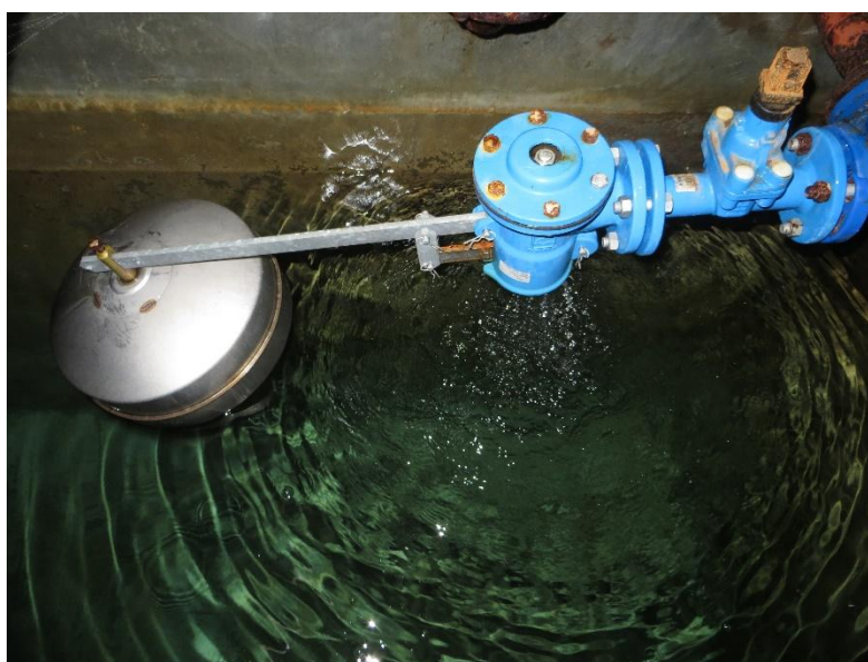
Suppression de Mussy Vauban
